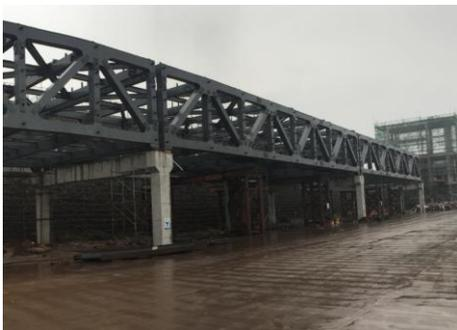
用途：将散料通过皮带机从一个转运站输送到另一个。
