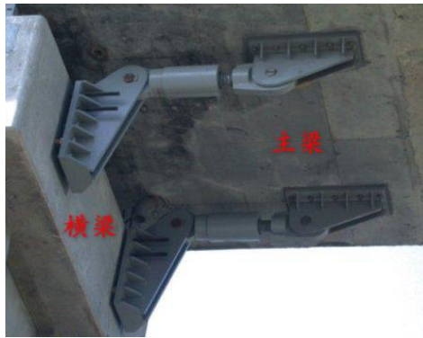
图 4-a 粘滞阻尼器的布置
